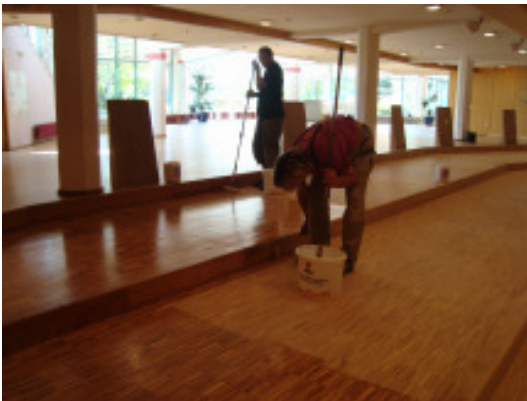
Bild_01 Andreas Schmid (Parkettleger) und Markus Franke Bei den Arbeiten
